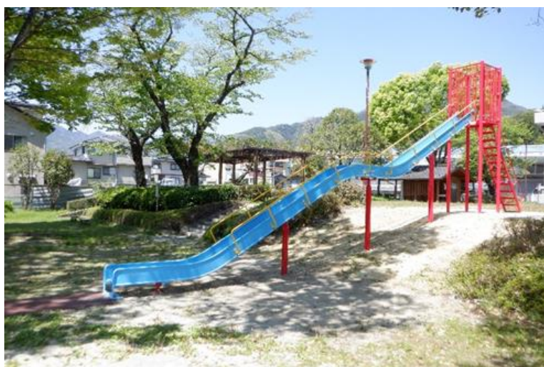
公園長寿命化修繕工事の施工状況 高羽1号公園
