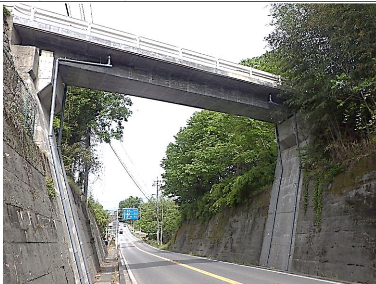
橋梁長寿命化修繕工事の施工状況 国道3号橋
