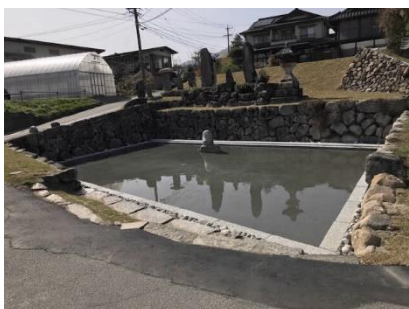
恒川史跡公園清水エリア第1期工事
